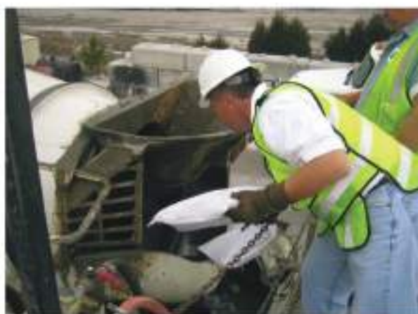
اضافه نمودن الیاف به صورت دستی
